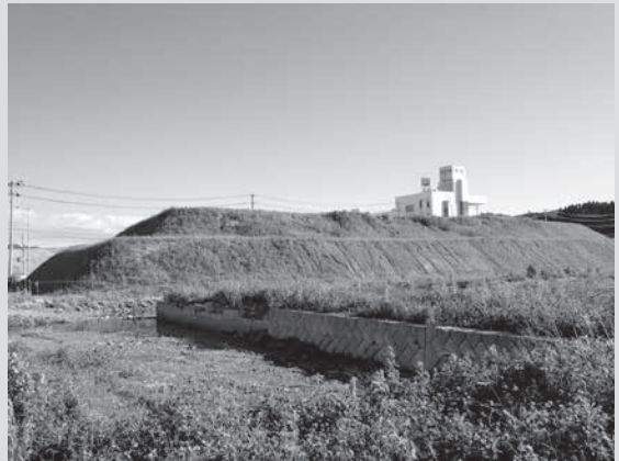
図2 南三陸町の公立志津川病院跡地
