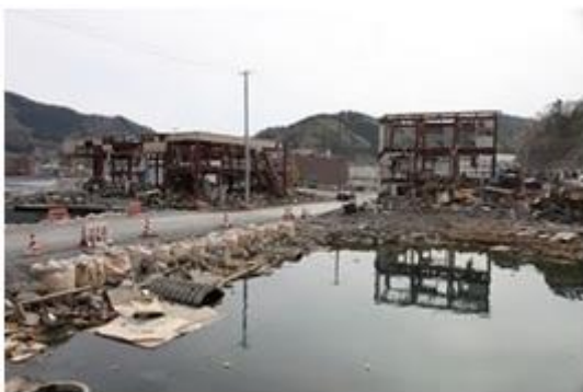
雄勝町の被災地区
