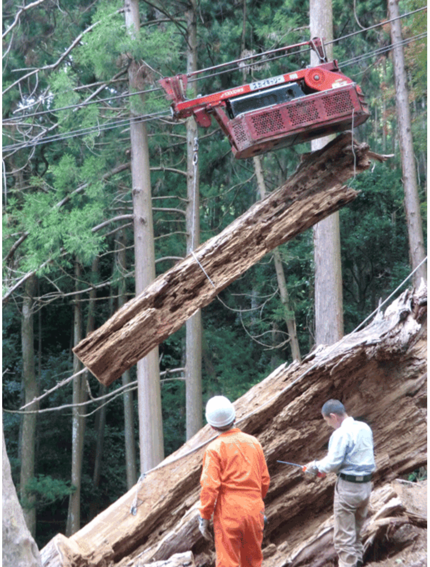
4トンまで吊り下げられるラジコンキャリアーで搬出作業中(2012年12月撮影)
